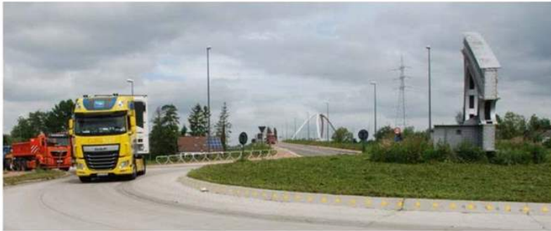
Het aansluitingspunt van de Nieuwe Maasweg met de brug. FOTO SYLVAIN LIEKENS
